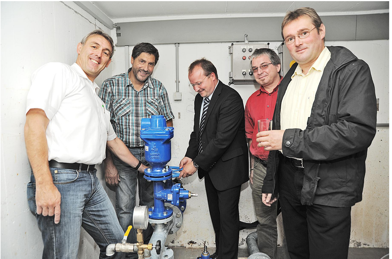
Symbolische Freigabe der Wasserversorgung (von links): Ulrich Kornhaas vom Ingenieurbüro Eppler, Karl Helfried Rath von der Baufirma Rath, Bürgermeister Andreas Hölzlberger, Bauamtsleiter Klaus Dezember und Beihingens Ortsvorsteher Thomas Burkhardt. Foto: Katzmaier
