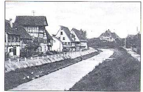
Bild 5a: Blick in Fließrichtung nach Ausbau 1898
