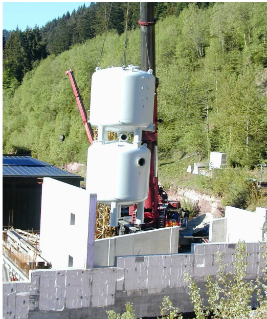
Bild 2. Aufstellung der Doppelstockfilter im Rohbau
