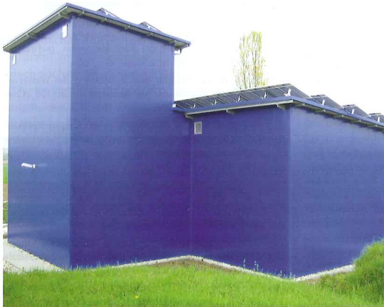
Bild 1. Das Wasserwerk Rotherst der Stadt Achern. © Hydro-Elektrik GmbH
