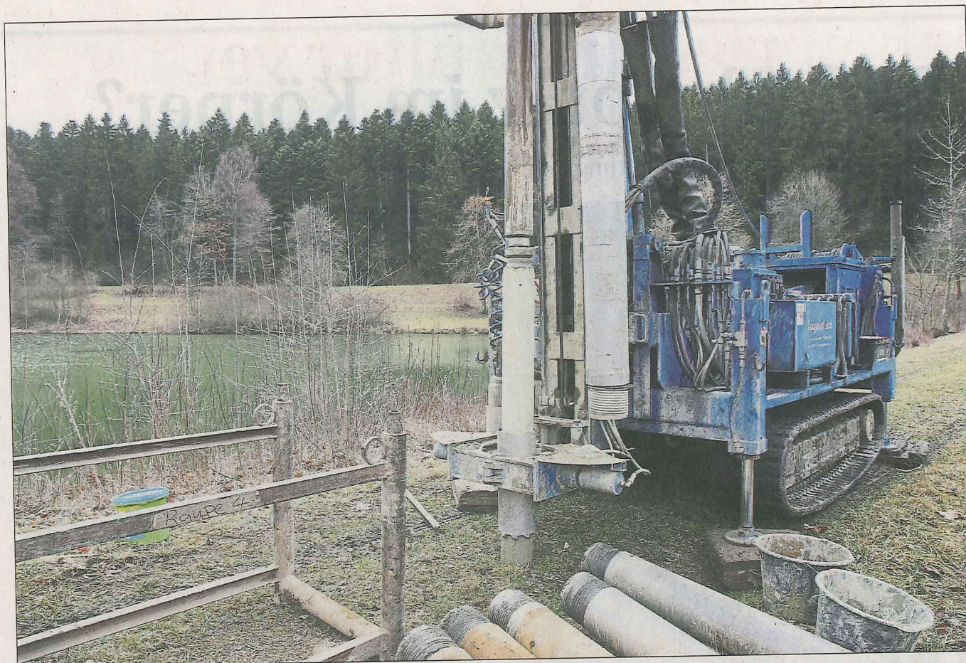
Dammbauwerke an Waldachtaler Seen stehen derzeit auf dem Prüfstand.
