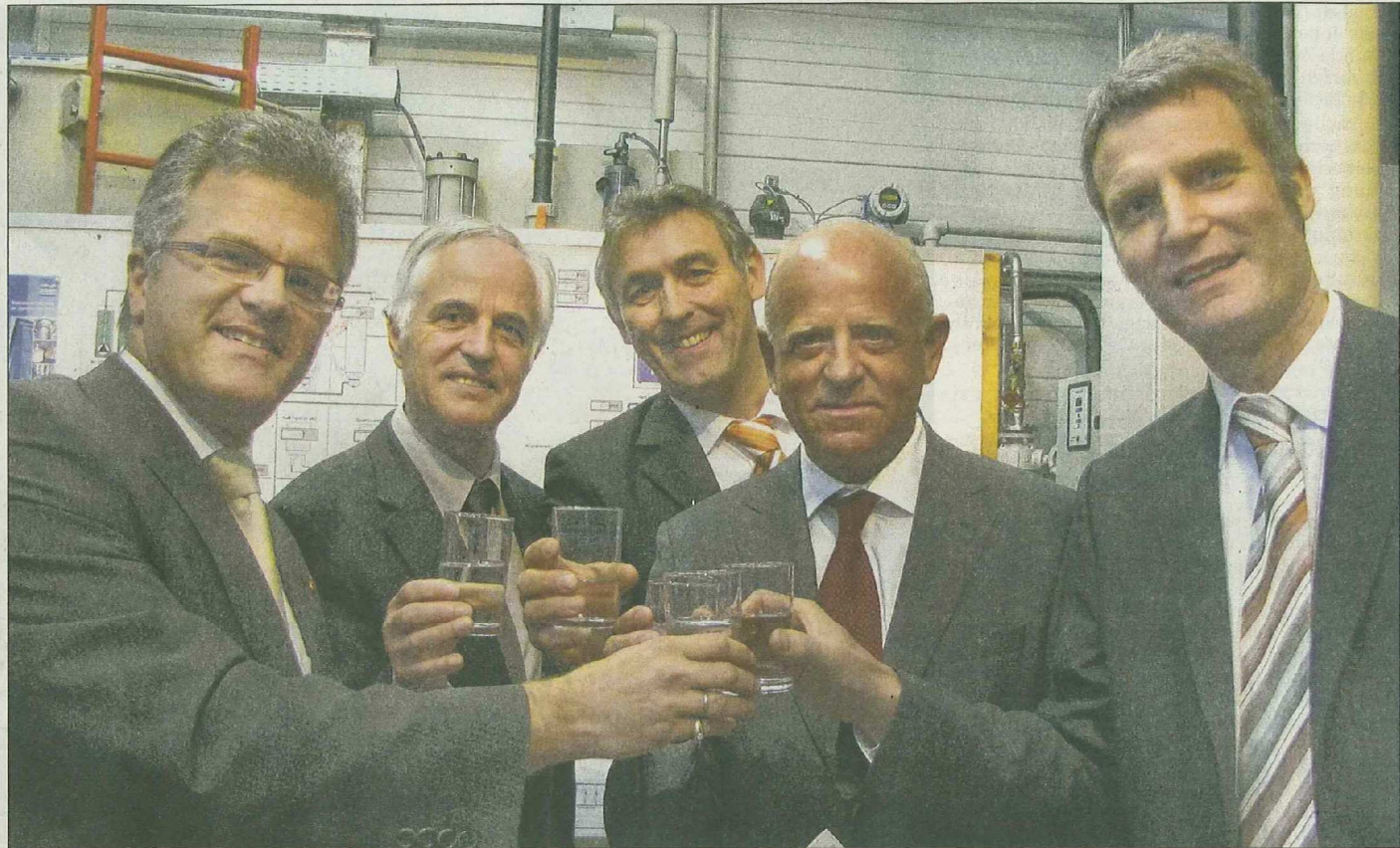
NA DANN PROSIT: Oberbürgermeister Hans Jürgen Pütsch, Projektleiter Ludwig Volz, Planer Ulrich Kornhaas, Initiator Rudolf Straub und Geschäftsführer Olaf Kasprzyk (von links) bei der offiziellen Inbetriebnahme der Enthärtungsanlage im Wasserwerk in Ottersdorf. Foto: ler
