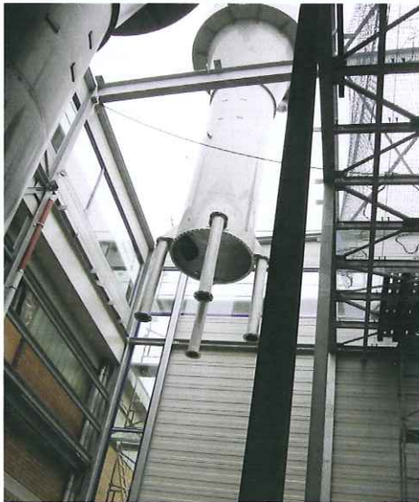
Montage Enthärtungsreaktor
